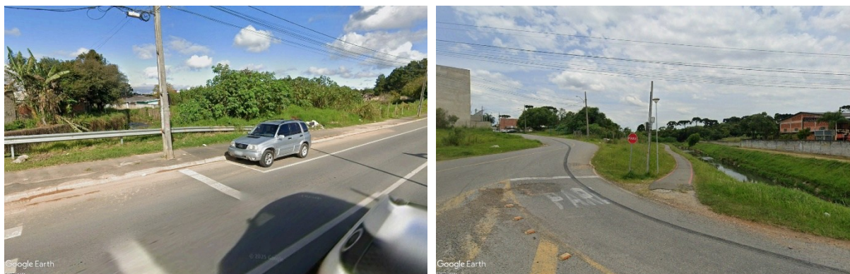
Figura 20: Ausência de sinalização, presença de obstáculos e largura insuficiente em calçada compartilhada
